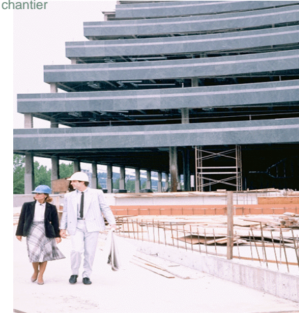
Le suivi du chantier
